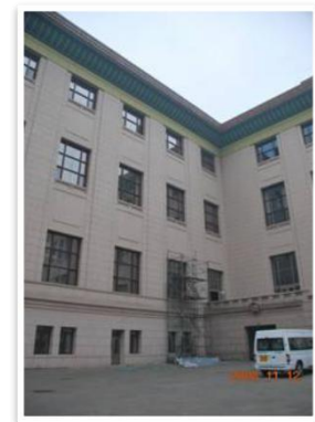
人民大会堂建筑外窗检测
